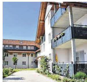
An den großzügigen Balkonen dienen die Wohnungen im bisherigen Missionshaus zu erkennen.
