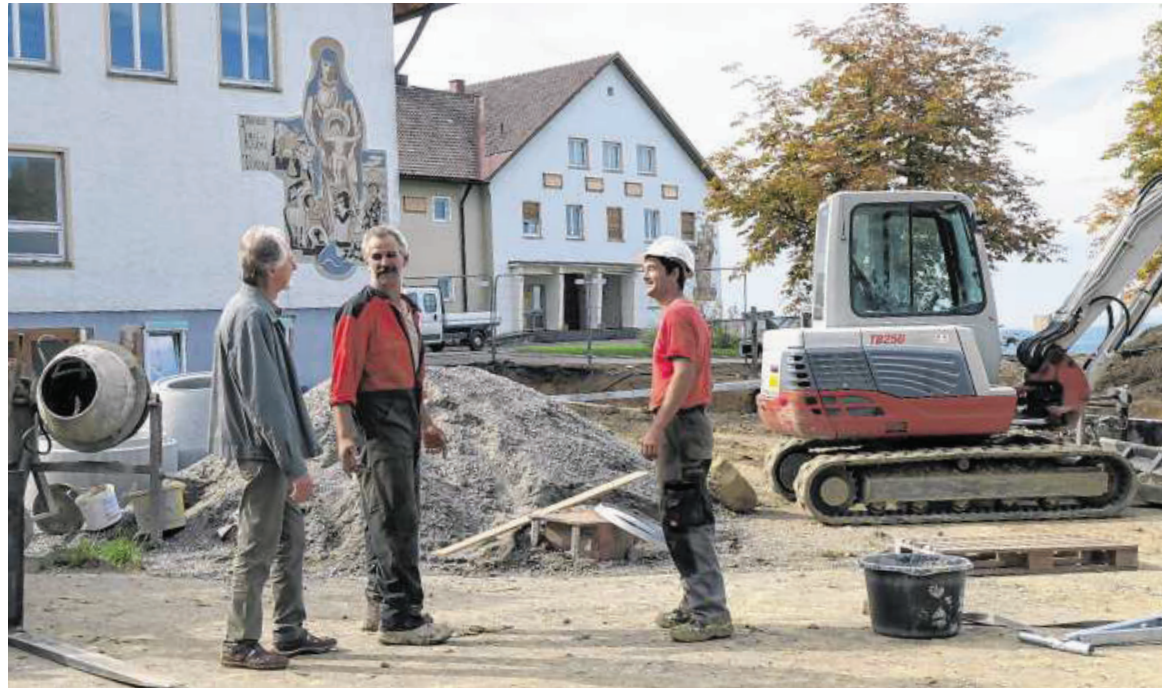
Die Bauherren Bernhard Zanker und Paul Rief (von rechts) sind froh, endlich alle Genehmigungen zu haben. Pater Dr. Werner Nidetzky (links) und seine Mitbrüder werden sich die nächsten drei Jahre mit einer Baustelle arrangieren. Foto: Ingrid Grohe
